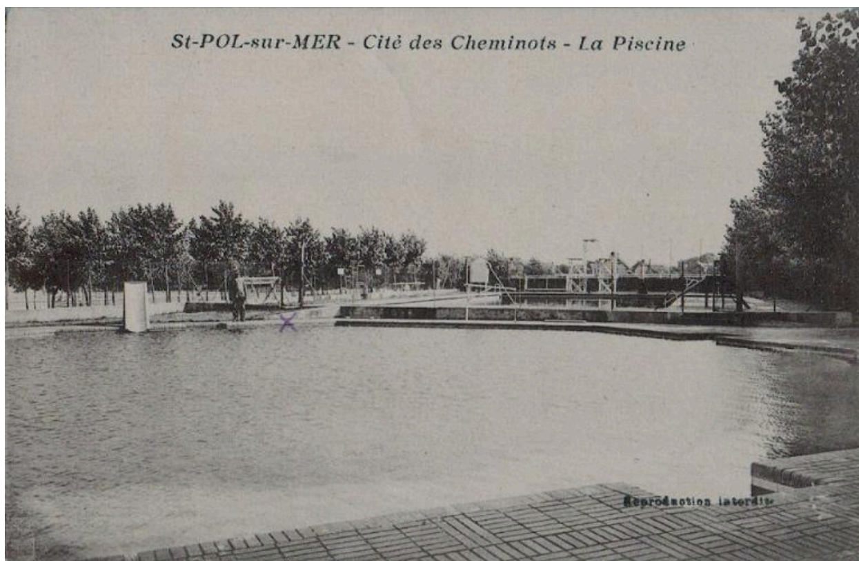
Vue du bassin-enfants de forme octogonale de la piscine de la cité des cheminots de Saint-Pol-sur-Mer, carte postale, vers 1930 (coll. part.).
