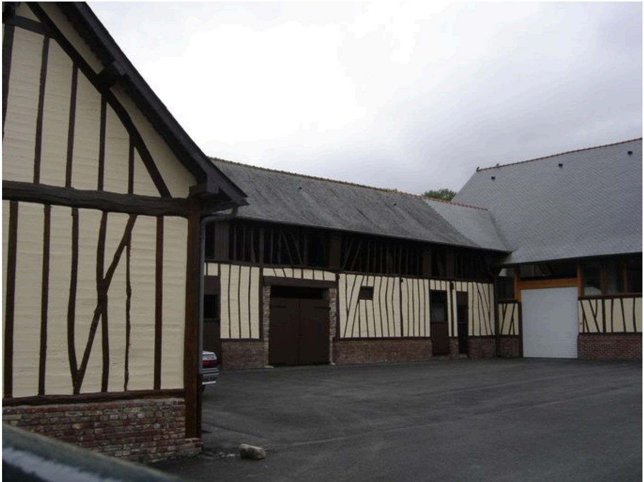
Vue des étables depuis la cour.
