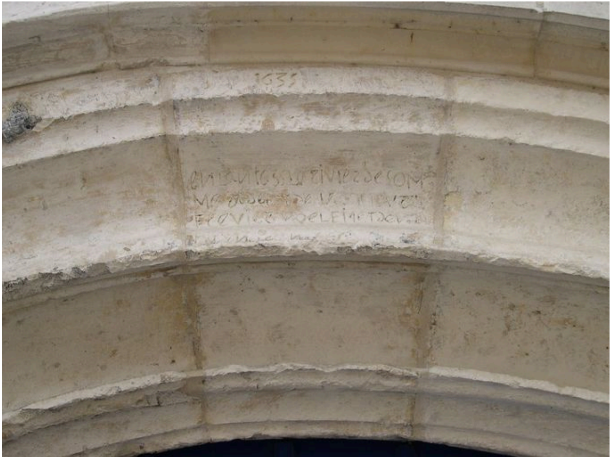
Vue de la façade sud : détail de l'inscription au-dessus du portail.
