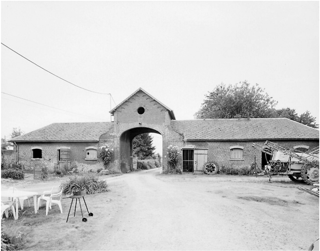
Vue du revers du porche et des écuries.
