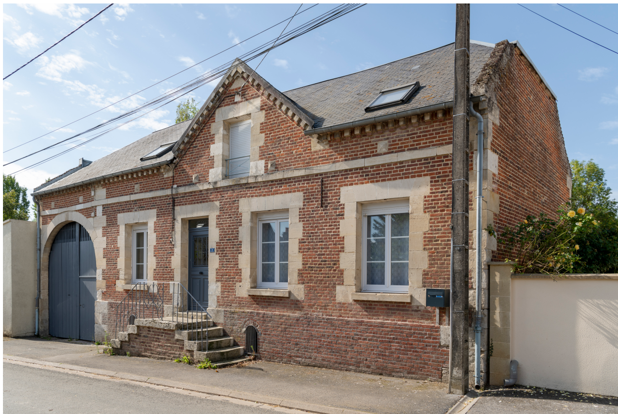
Logis sur rue, n°11 de la rue du Petit Paris, vue prise depuis le nord-est.
