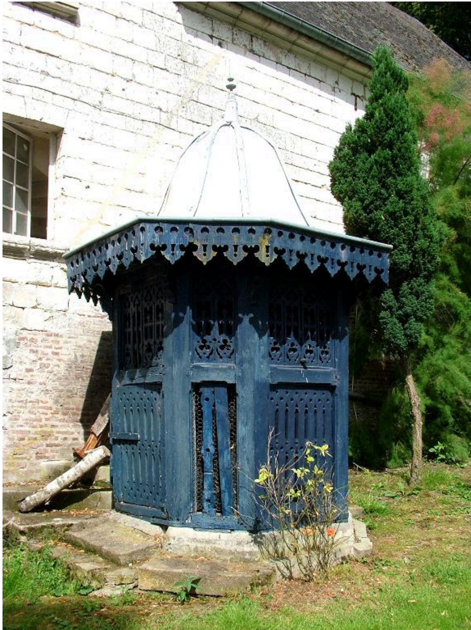
Puits dans la basse-cour.
