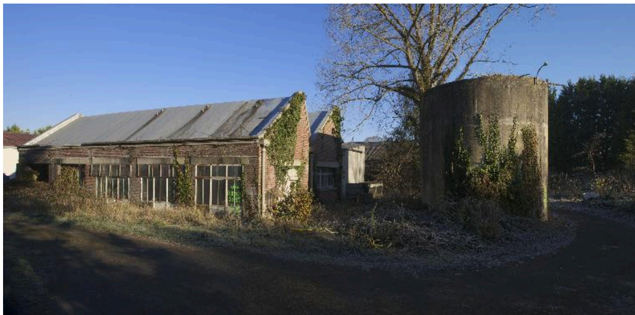
Vue générale de l'atelier de menuiserie et du réservoir d'eau.
