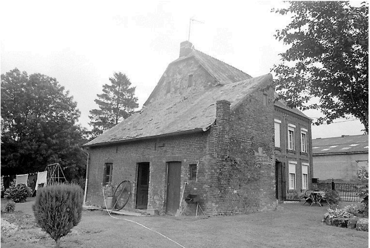
Vue du logis avec, au premier plan, l'atelier de fabrication.
