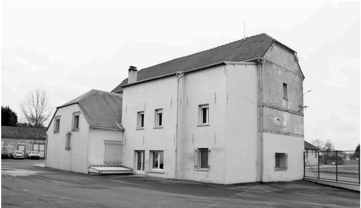
L'ancien moulin à blé : façade postérieure.
