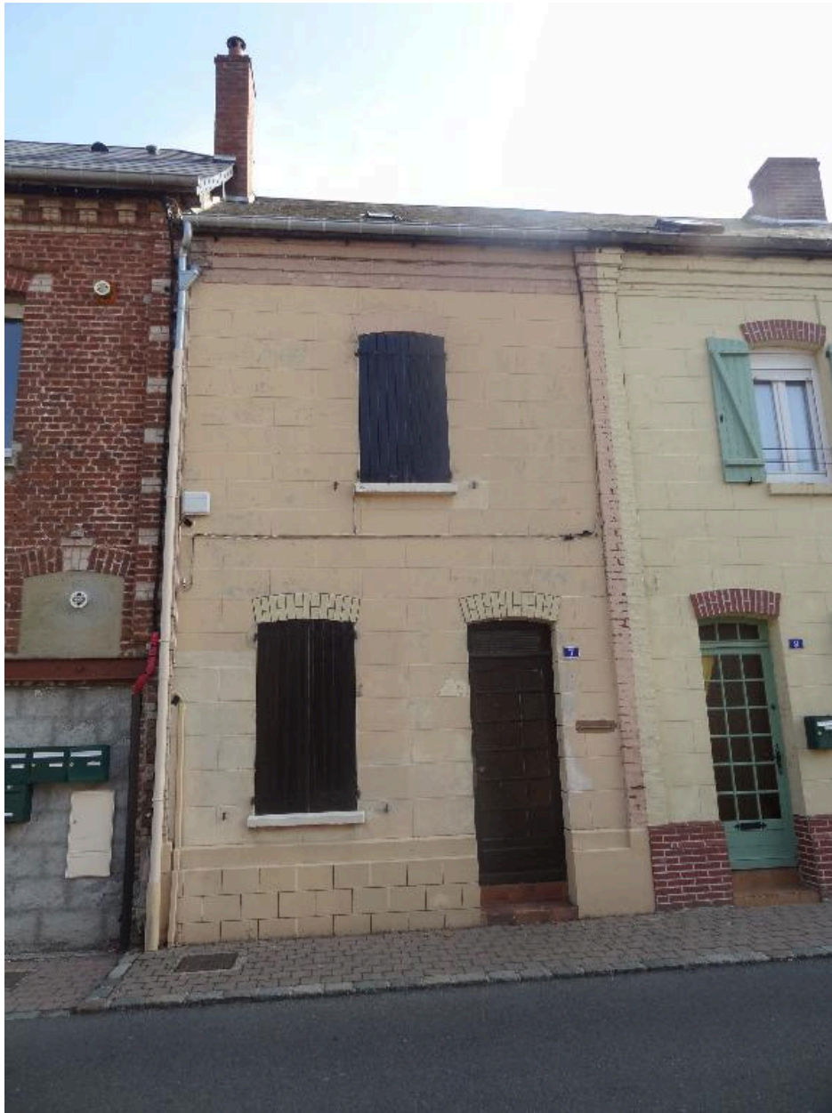
Vue générale d'un des logements de l'ensemble.
