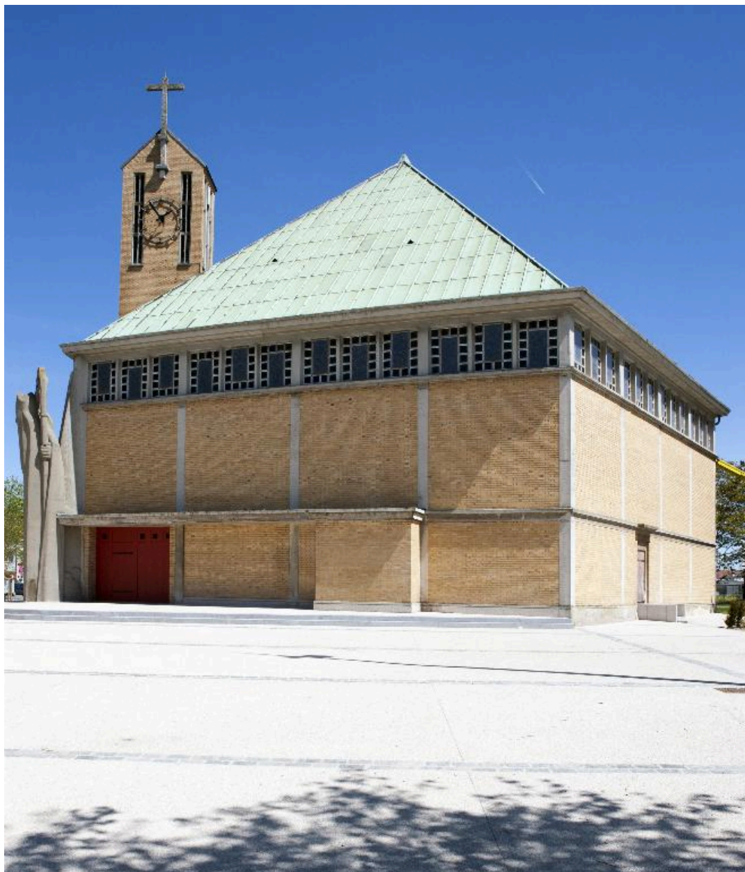
Élévation sud et est de l'église.
