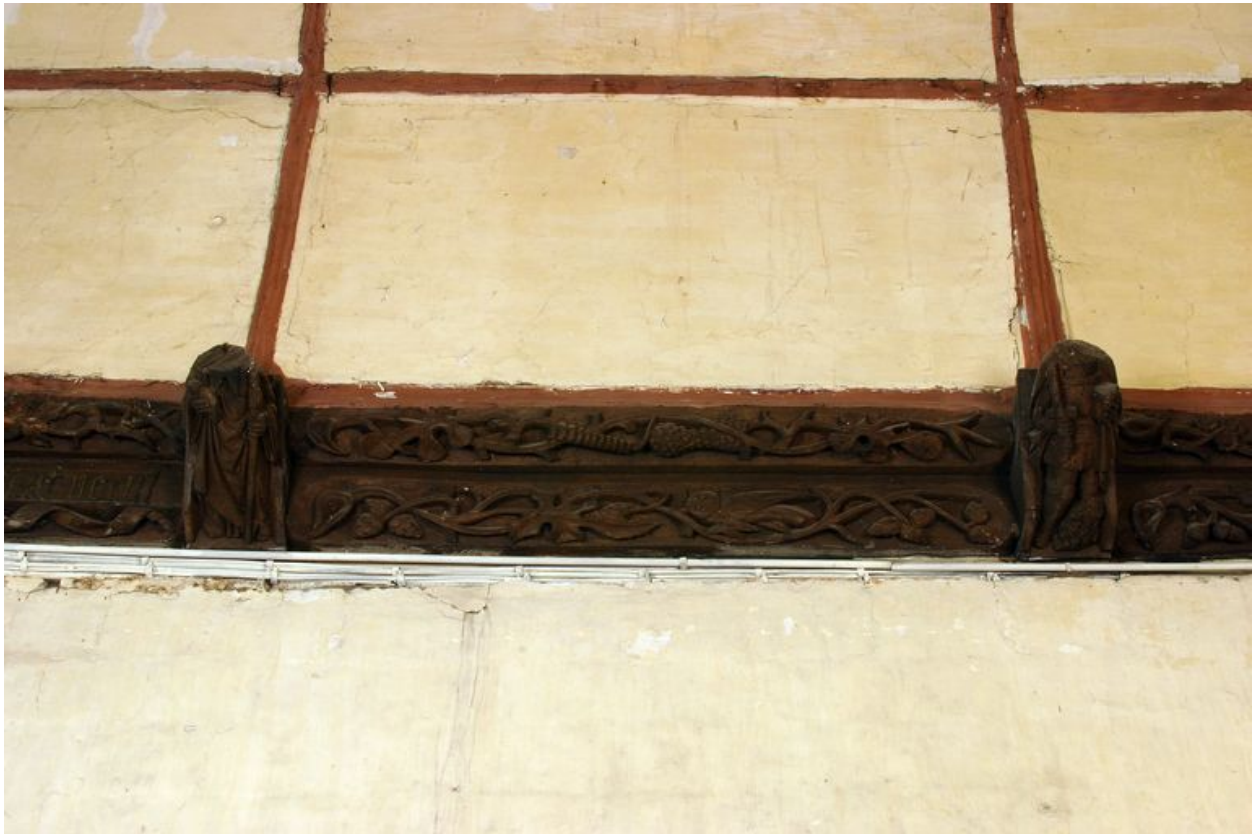
Vue détaillée de la sablière haute du choeur avec décor végétal et blochets bûchés.
