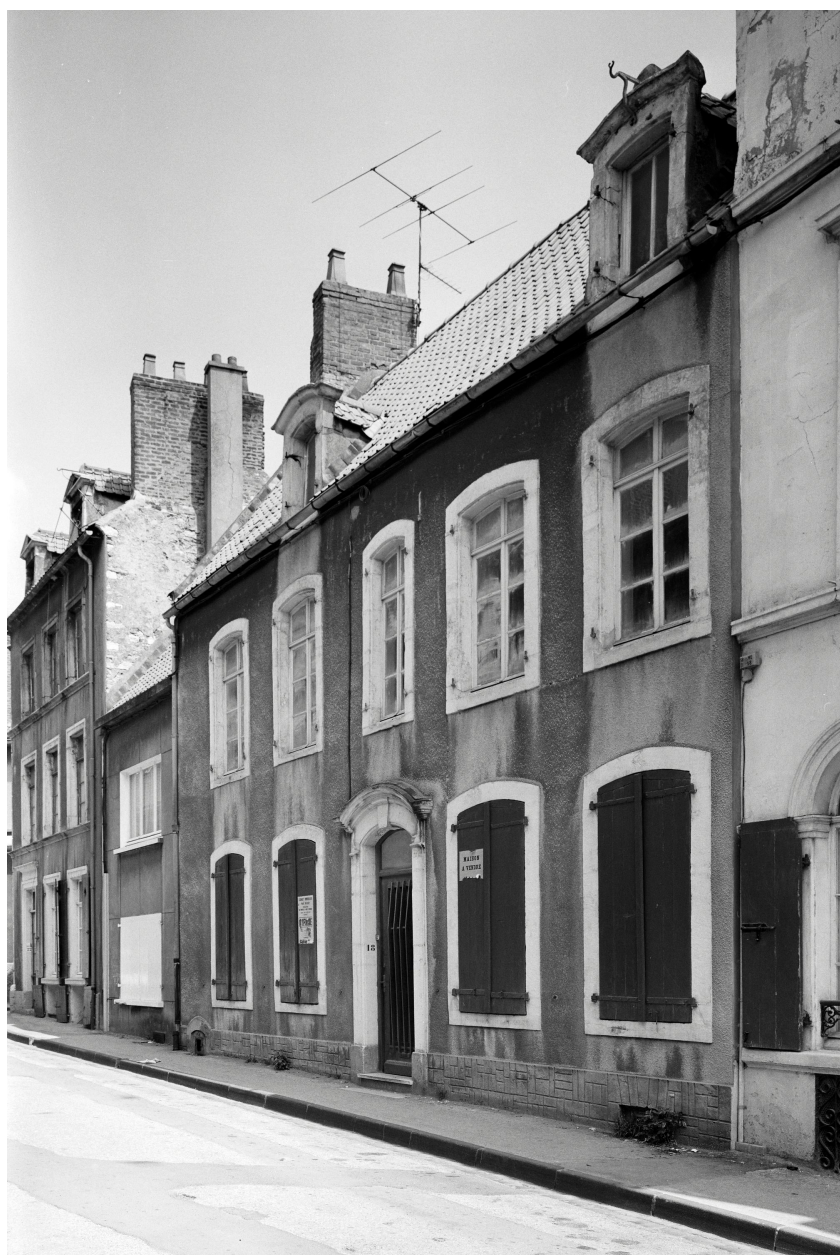
Maison, 18 rue Saint Jean.
