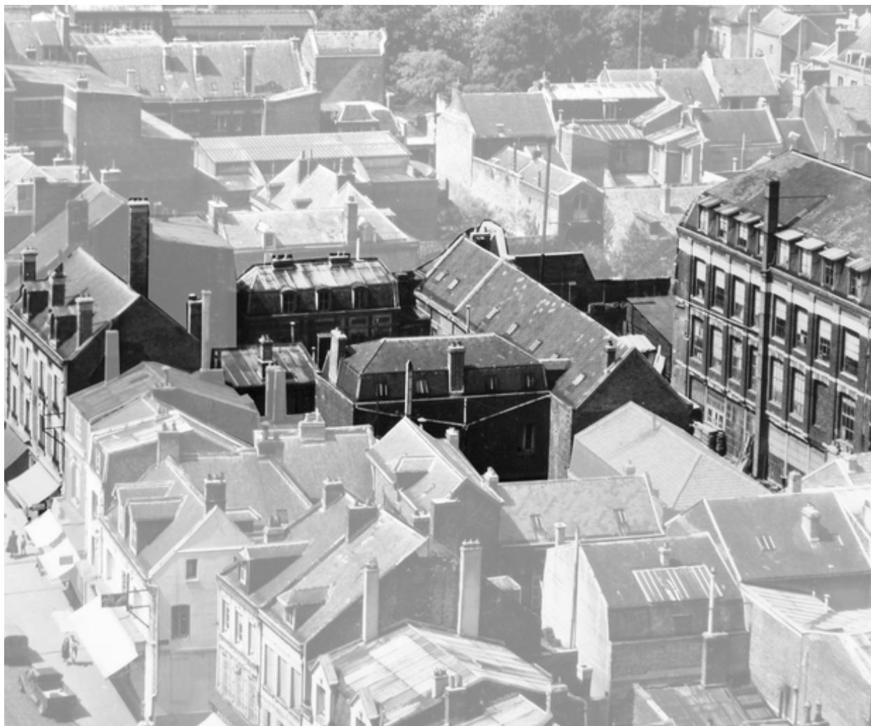
Vue aérienne du site vers 1950-1960 (AD Aisne).
