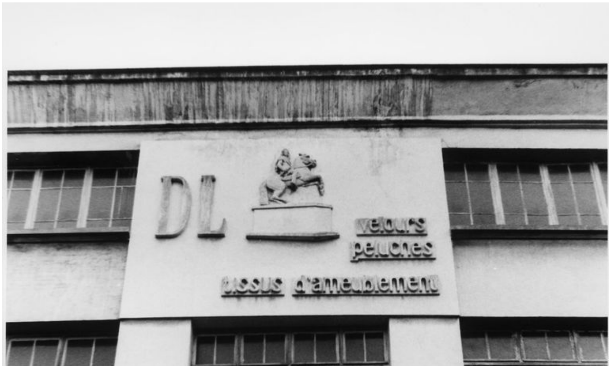
Détail sur le cartel de l'entreprise Delaroière et Leclercq.
