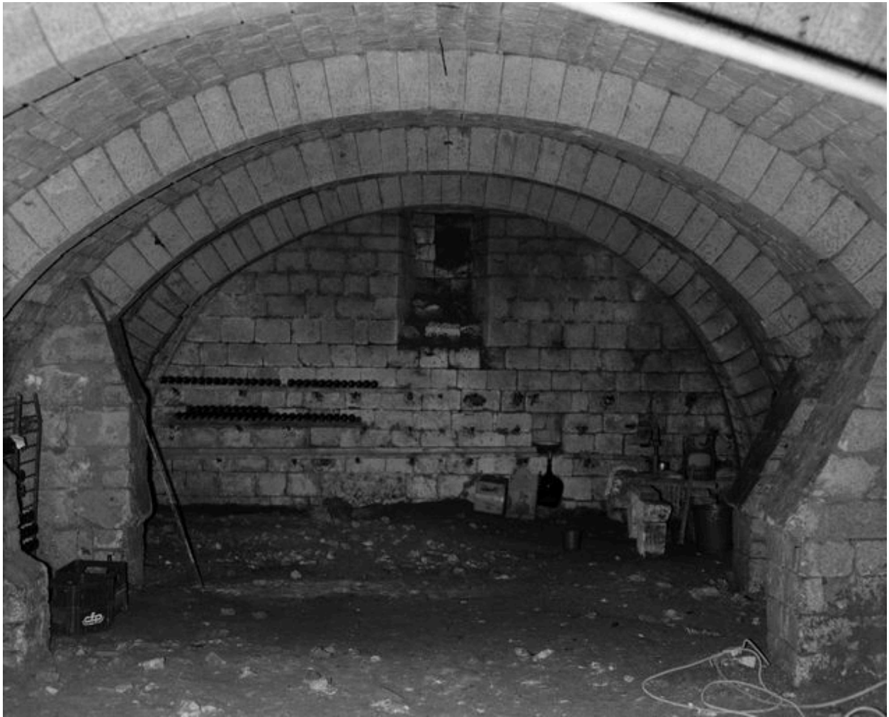
Premier étage de sous-sol.
