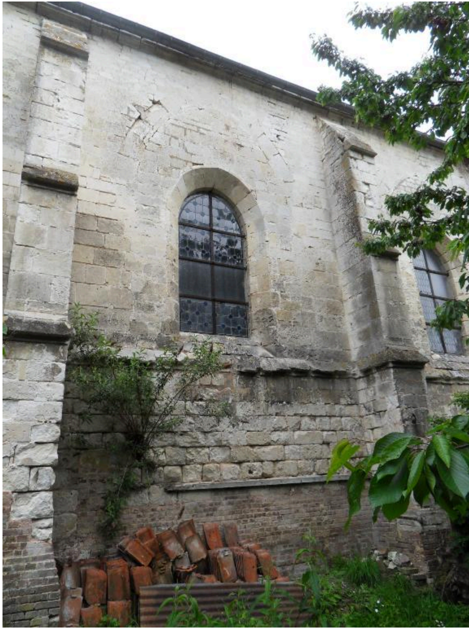
Baie du mur sud (deuxième travée).
