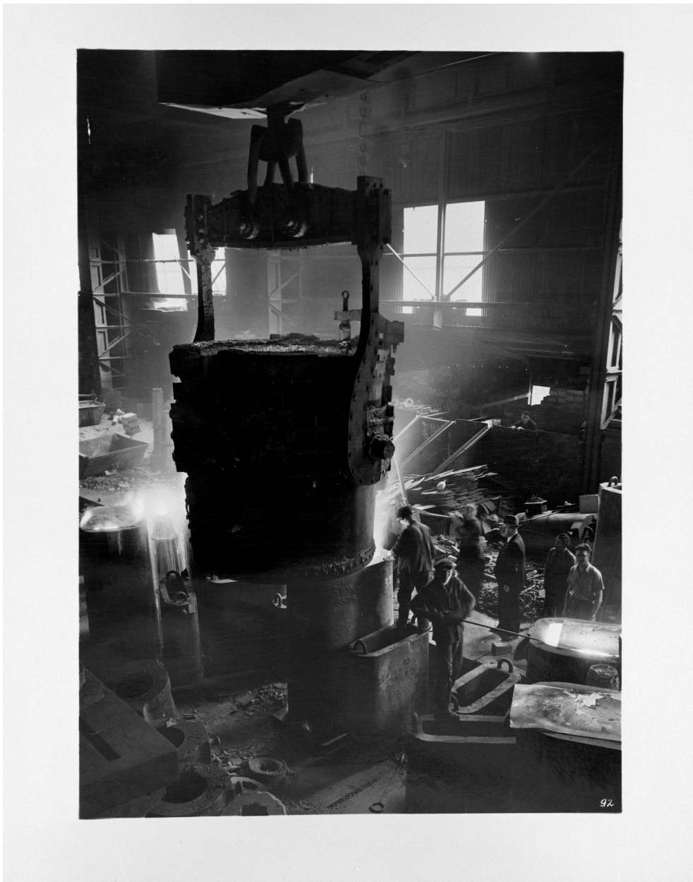
Bassin de coulée de l'aciérie : vue rapprochée de la "poche" de 50 t (?) d'acier en fusion. Photographie ancienne, auteur inconnu, sans date (coll. part.).
