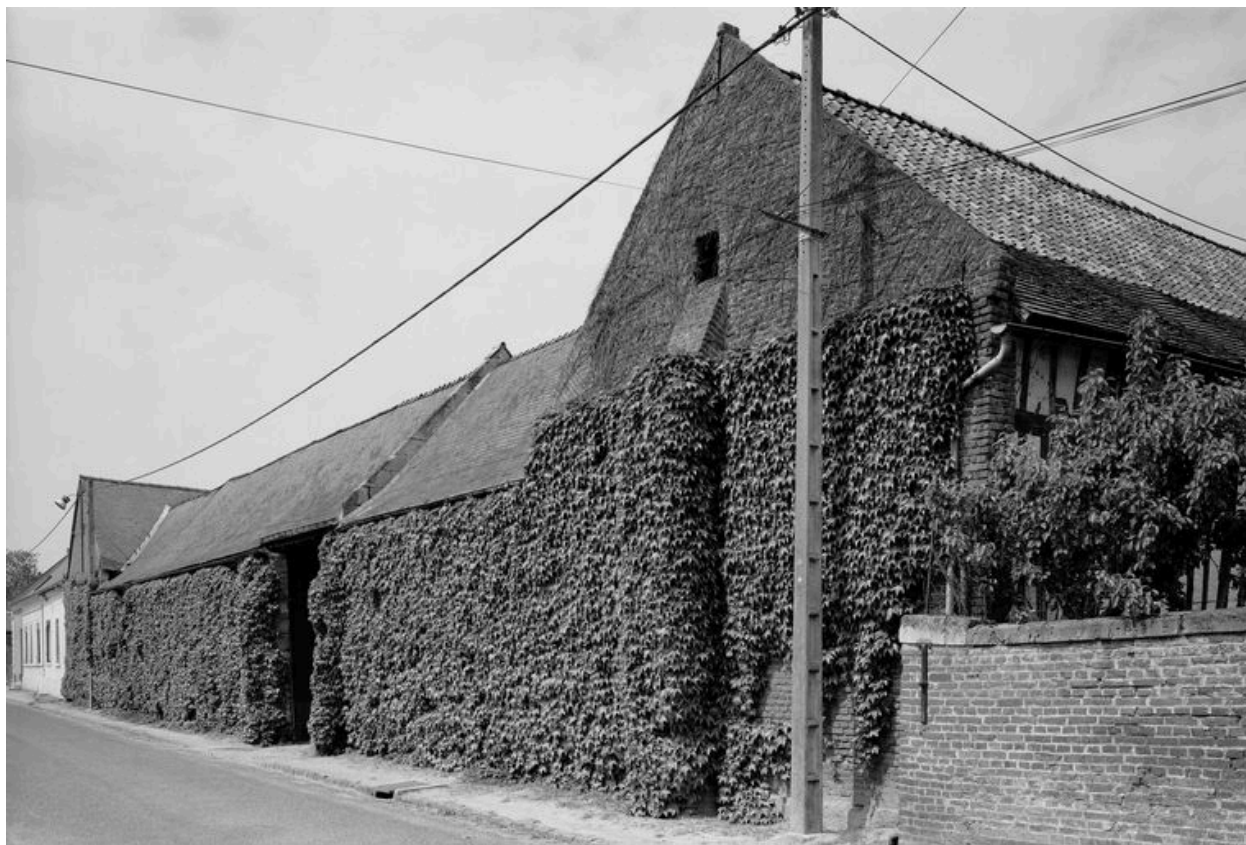
Vue générale sur rue.
