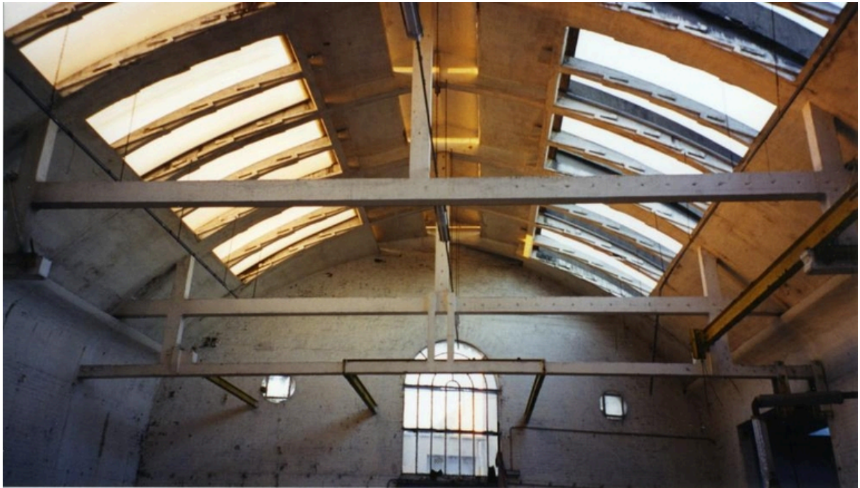
Vue intérieure de la blanchisserie, 2001.
