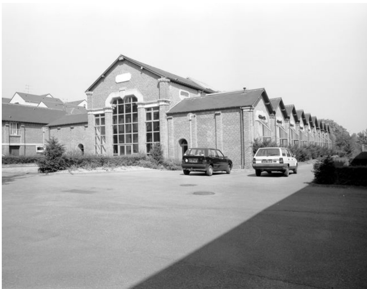
Pignon sud de la partie des abattoirs construits en 1854.
