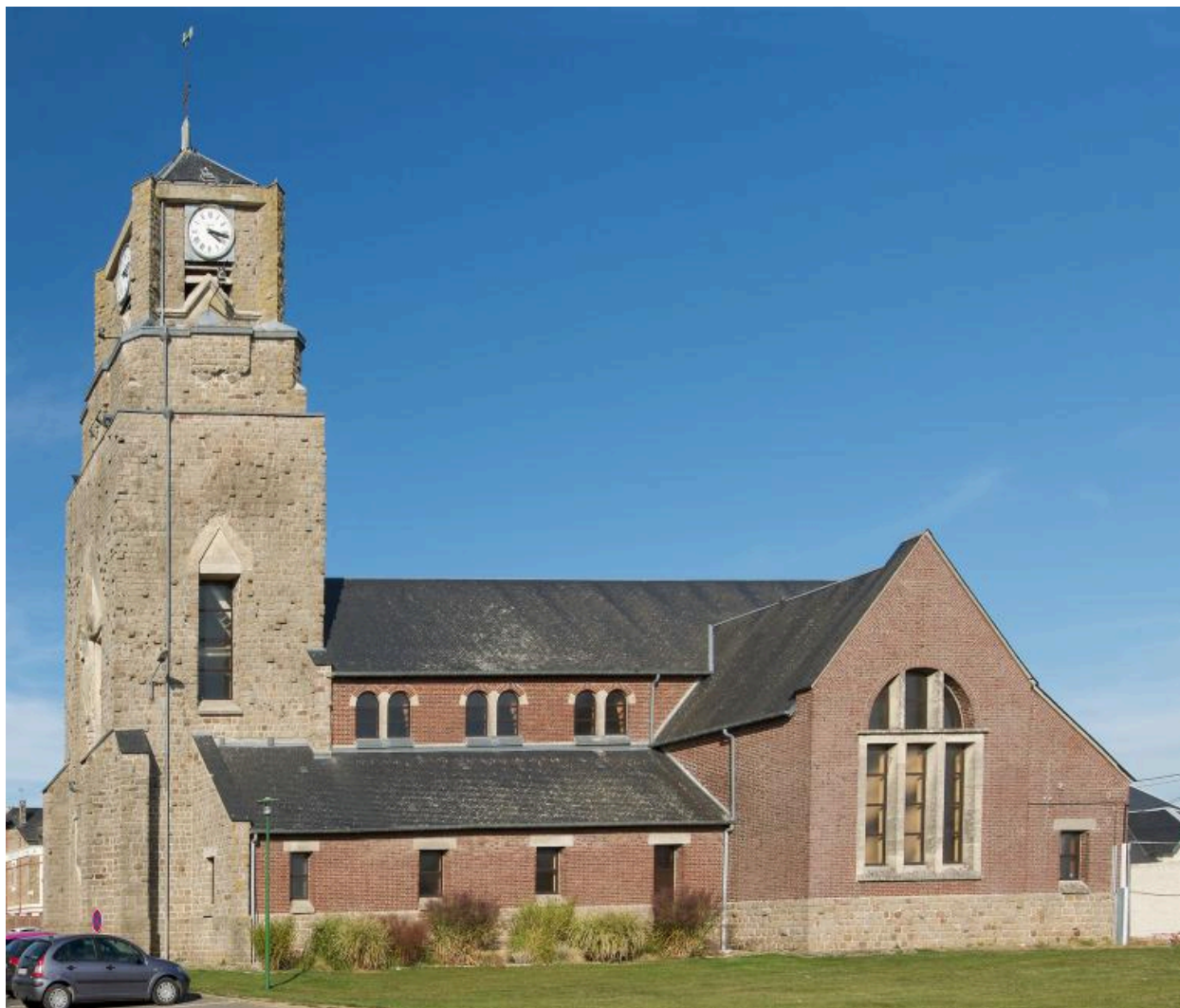
Façade latérale sud.
