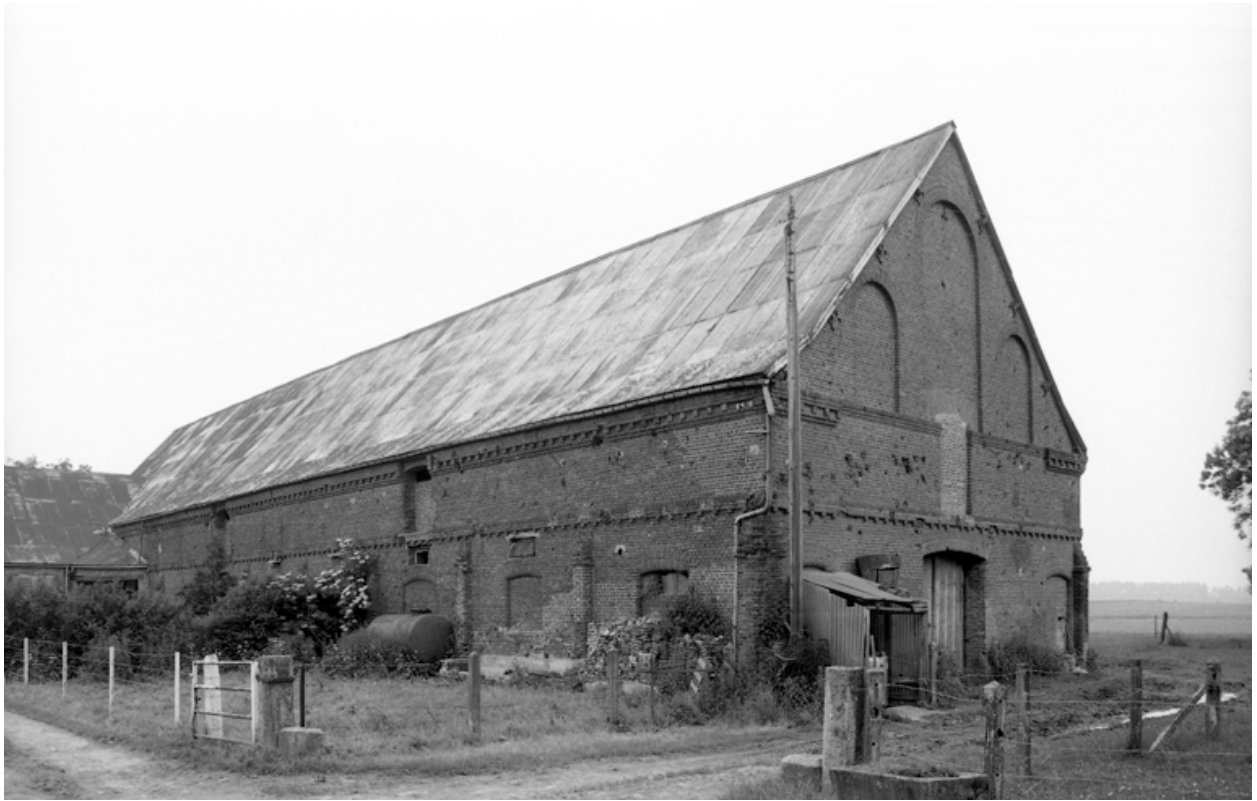
Vue de l'étable au nord-ouest.
