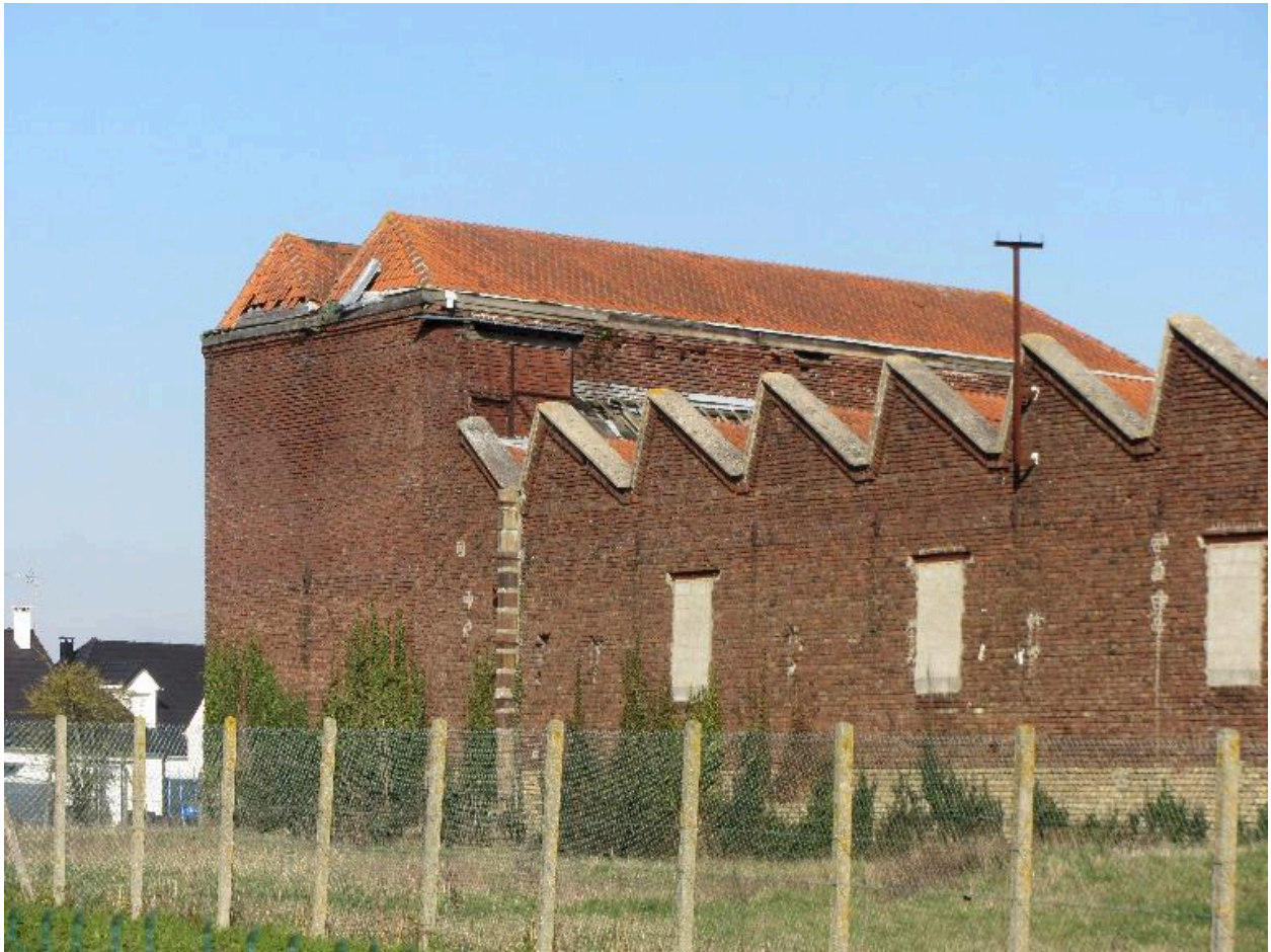
Détail des ateliers en shed de la teinturerie et de l'atelier de lissage.
