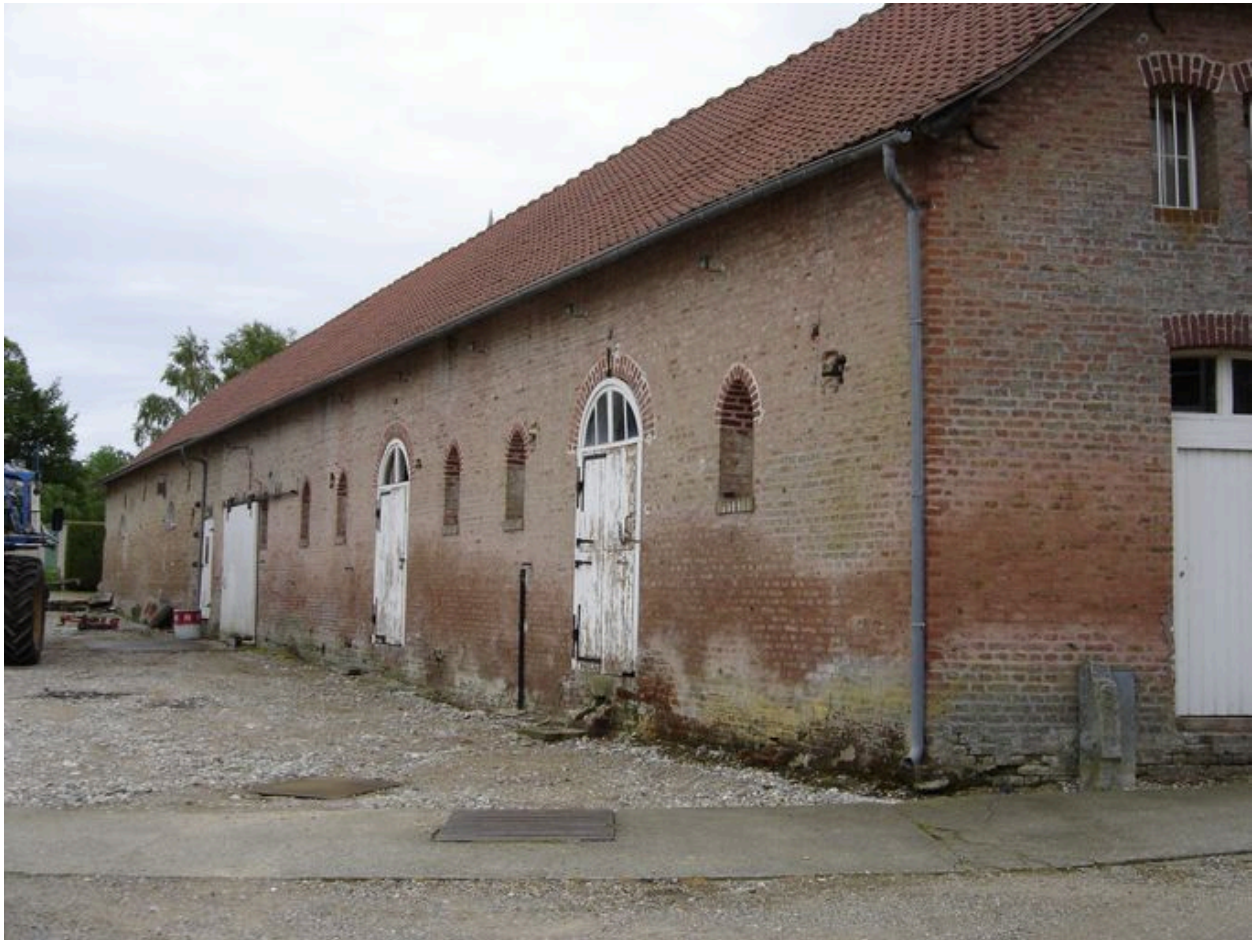
Face nord du bâtiment nord.
