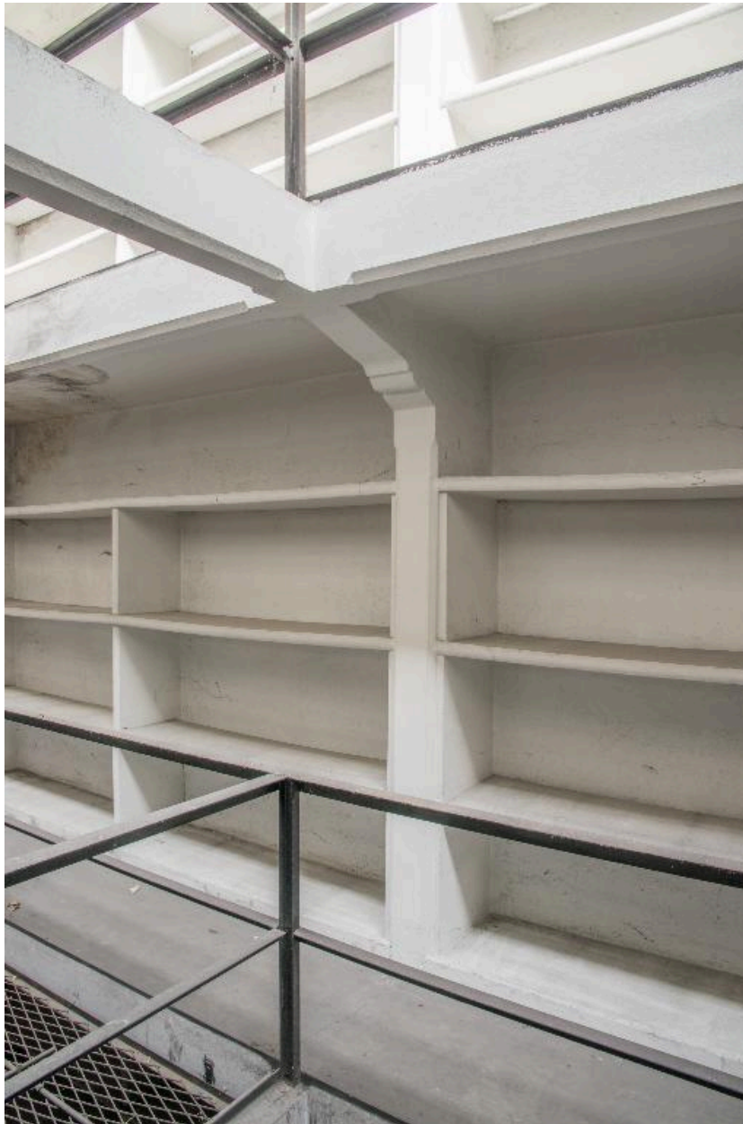
Bâtiment du dépôt, deuxième étage. Vue du système porteur en béton armé : pilier, console, entretoise.
