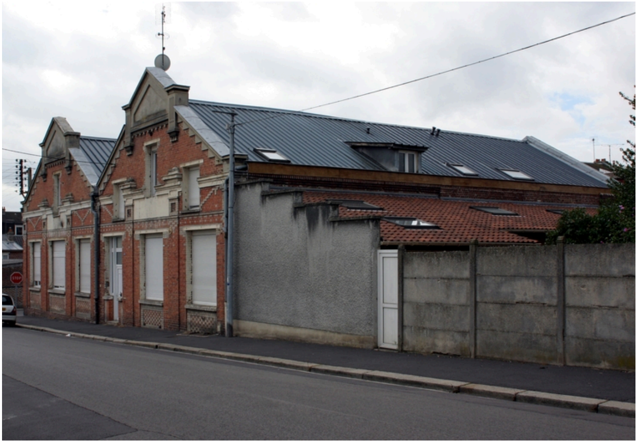
Façade antérieure des ateliers (pignons nord-est).
