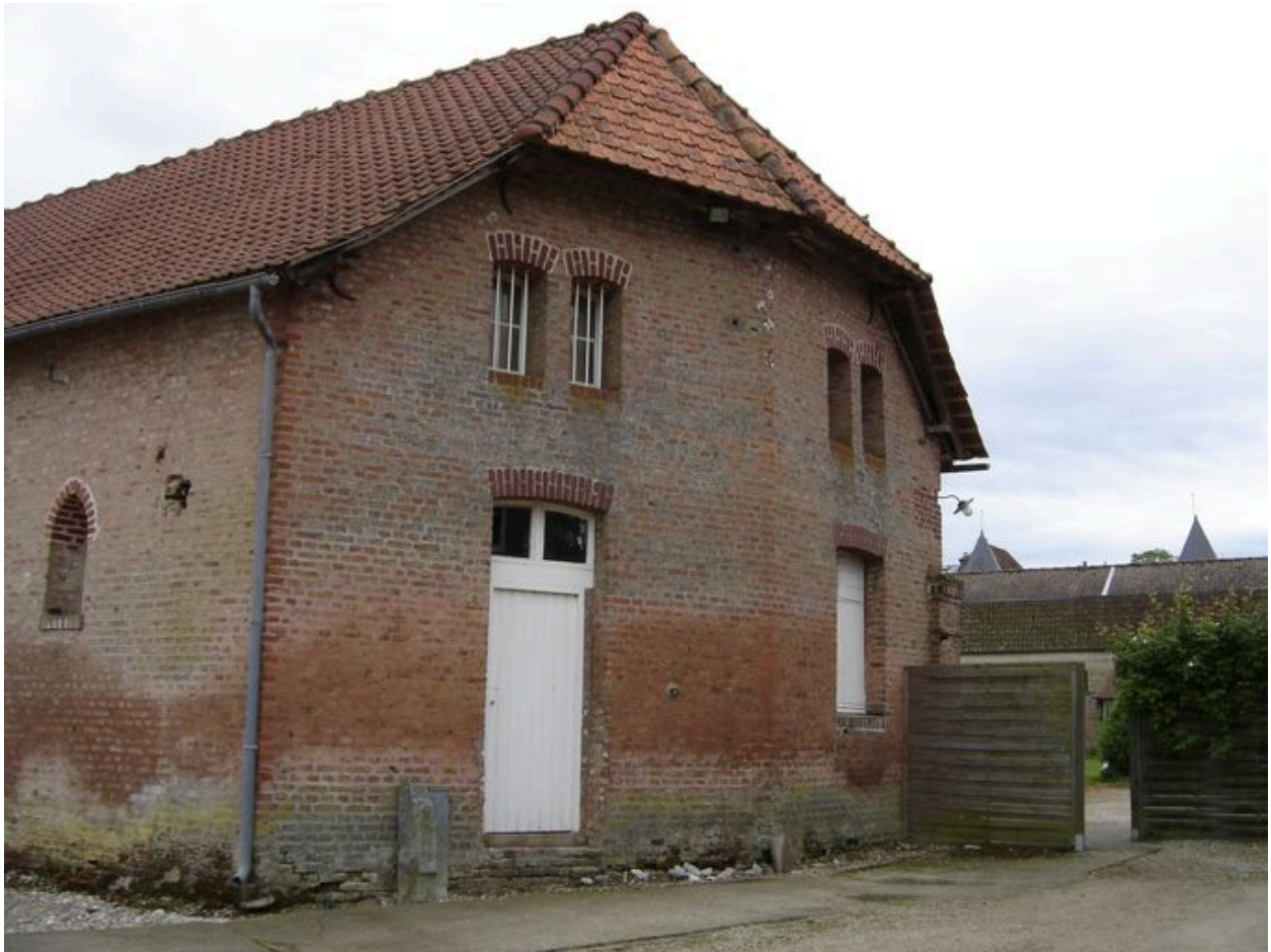
Pignon occidental du bâtiment nord.
