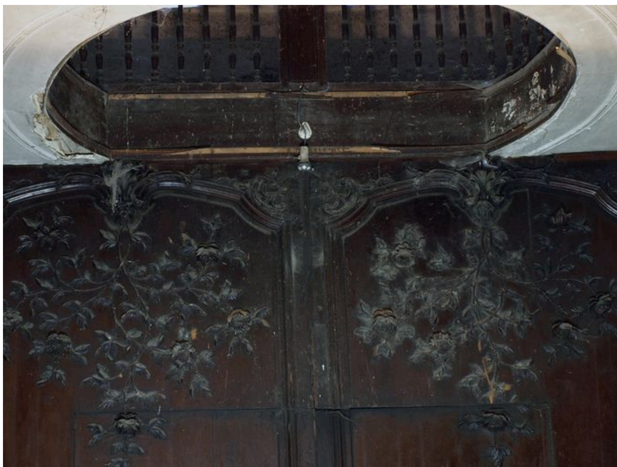
Vue de détail, partie supérieure
