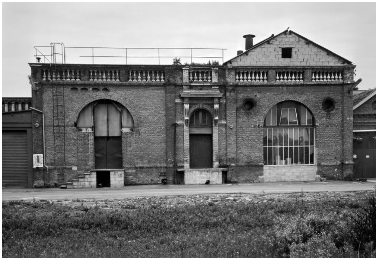
Chaufferie et salle des machines, flanc est.
