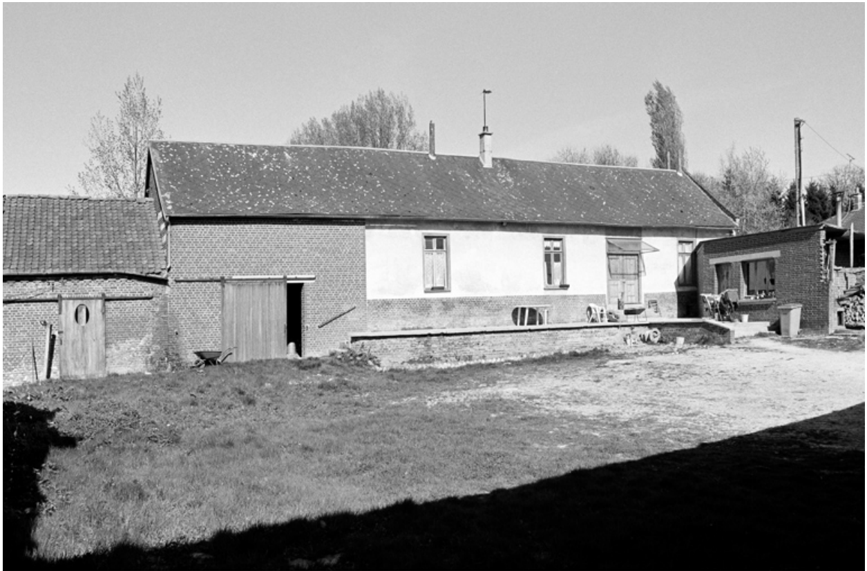
Côté nord-ouest de la cour de ferme : le logis et les étables en prolongement.
