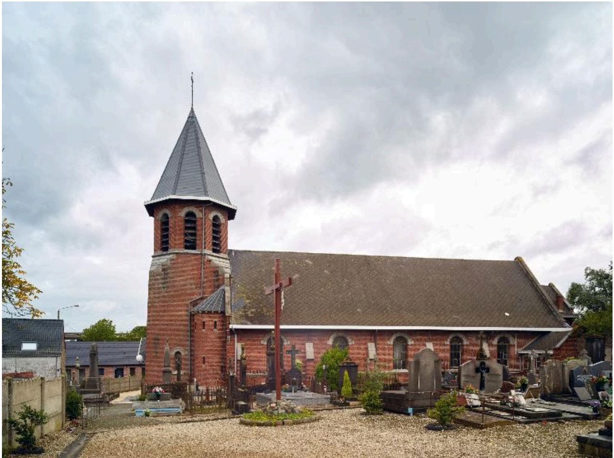
Vue générale de trois quarts, élévation sud.
