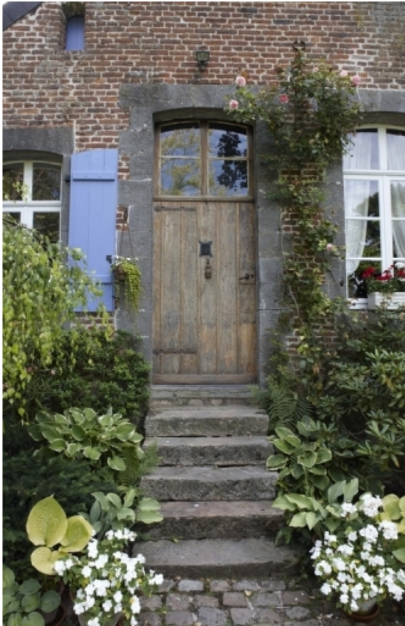
Détail de la porte d'entrée sur cour.
