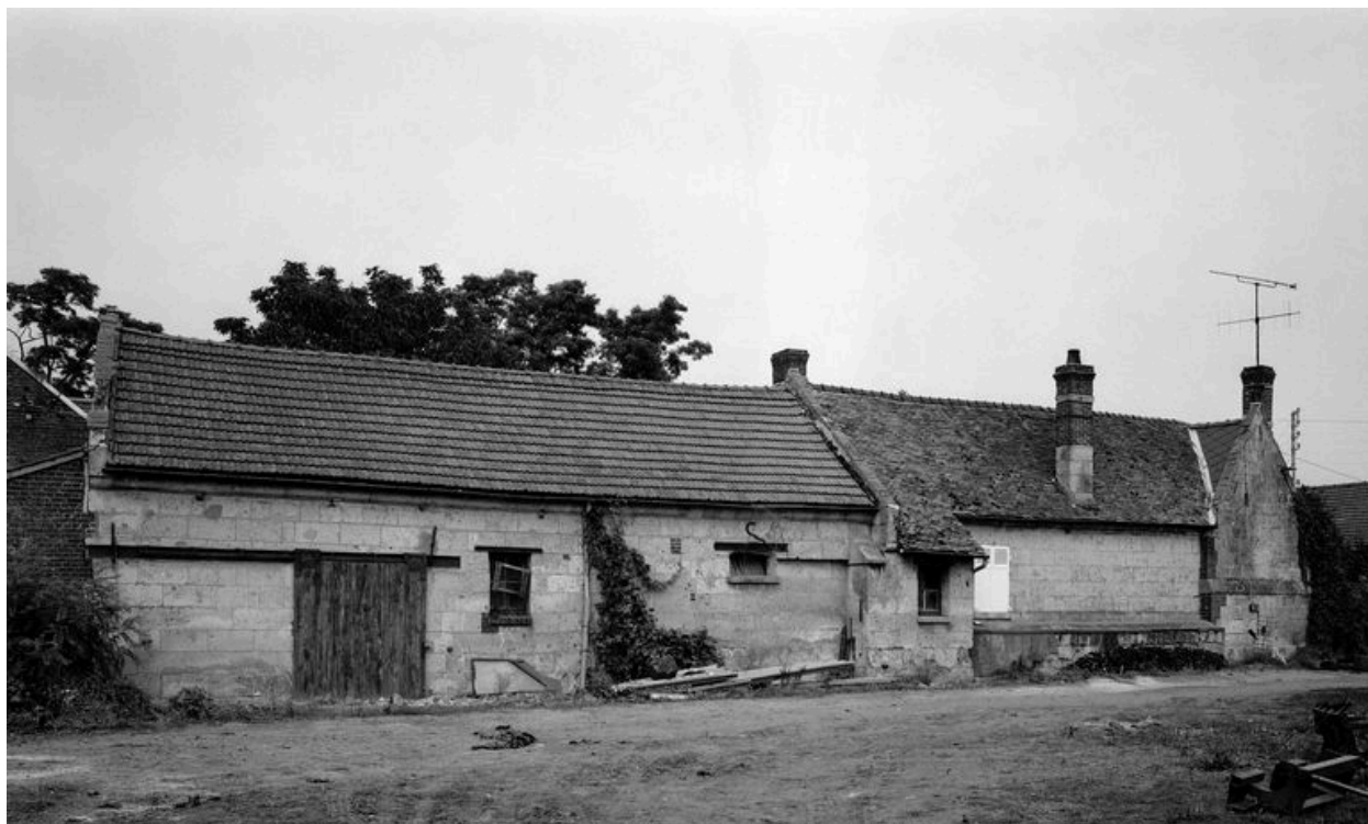
Second logis, four et étables. Élévation postérieure.
