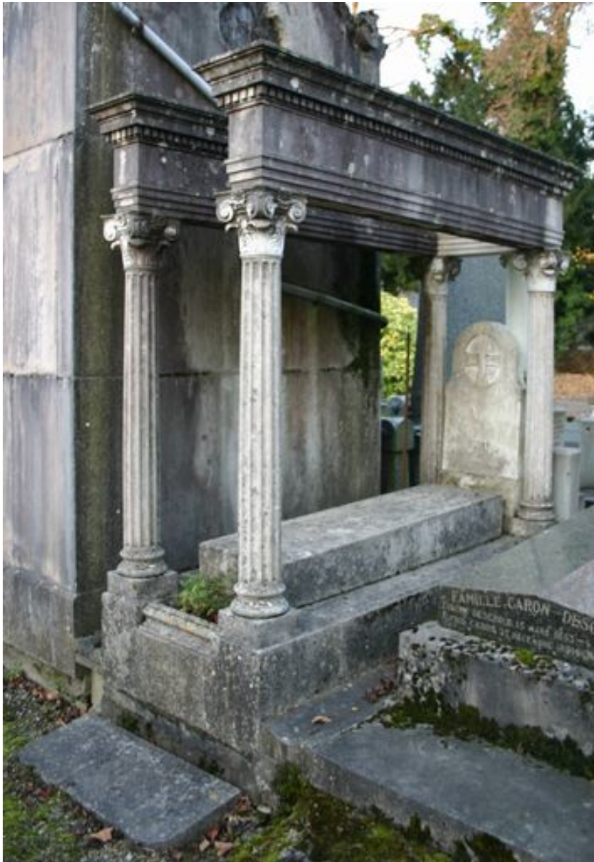
Vue générale, depuis le côté.
