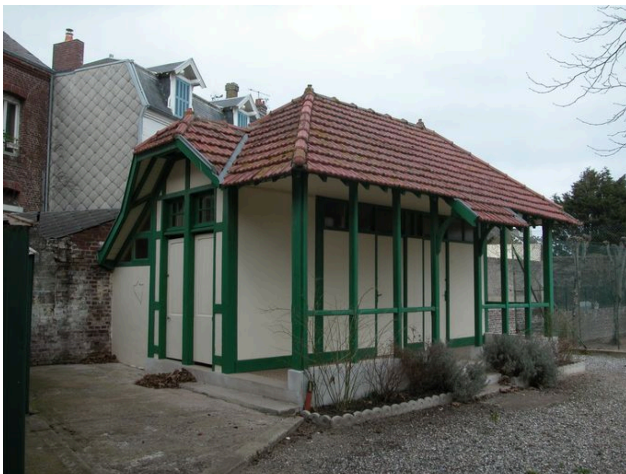
Les vestiaires, vue de trois-quarts.
