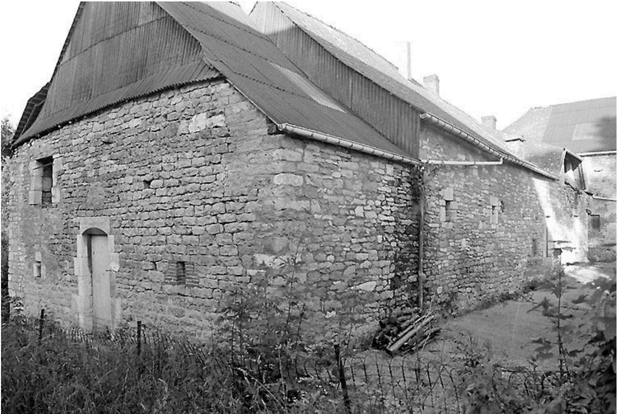
Elévations postérieures de la grange ouest et du logis.
