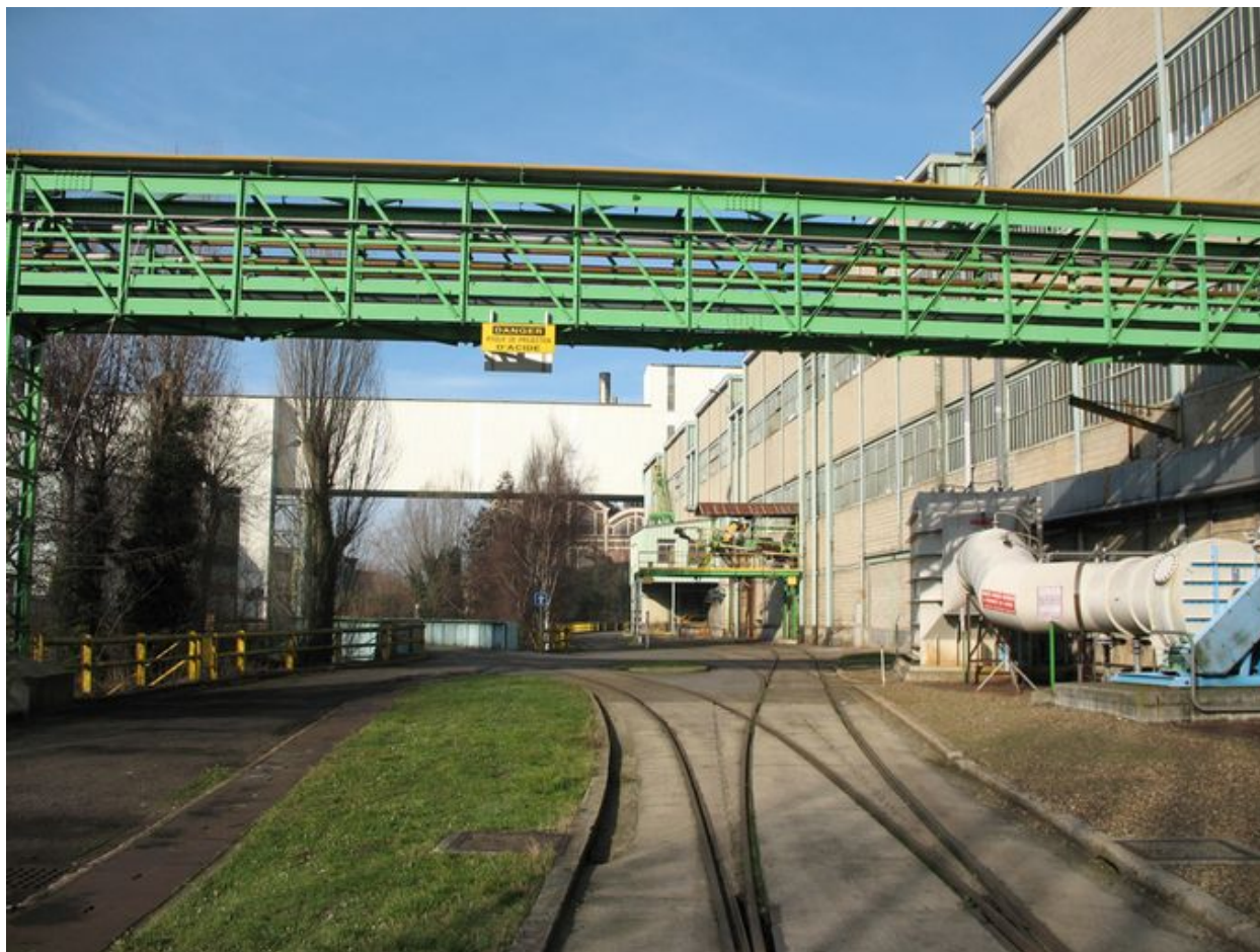
Rails longeant les ateliers abritant le laminoir.
