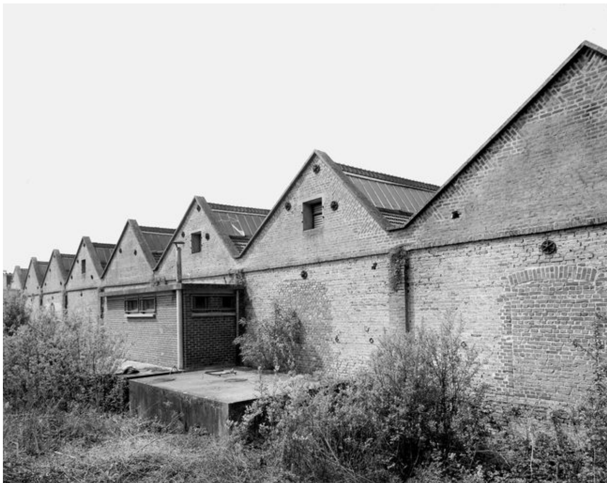
Pignon de l'atelier de tissage, état en 1988.
