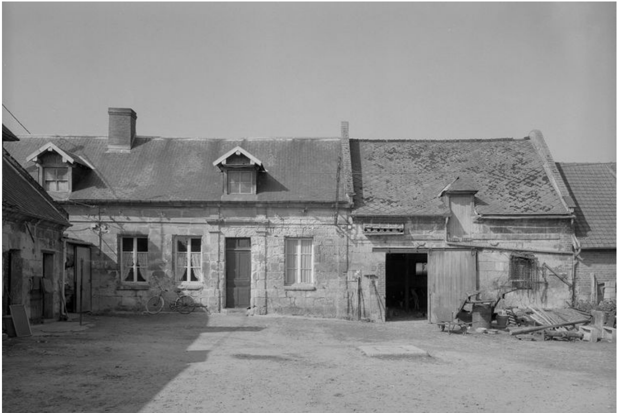
Logis. Elévation antérieure.
