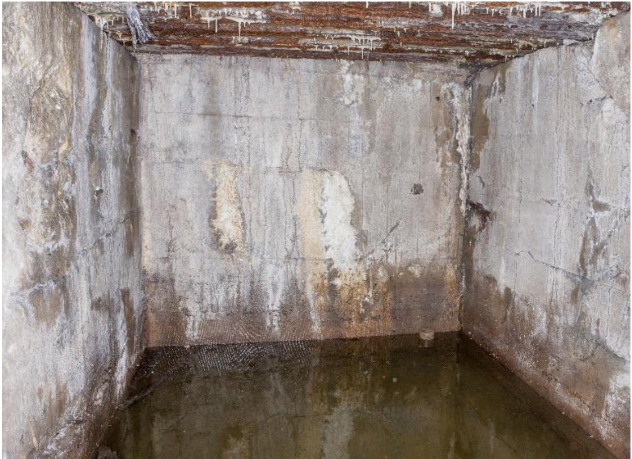
Casemate A. Arrière salle.
