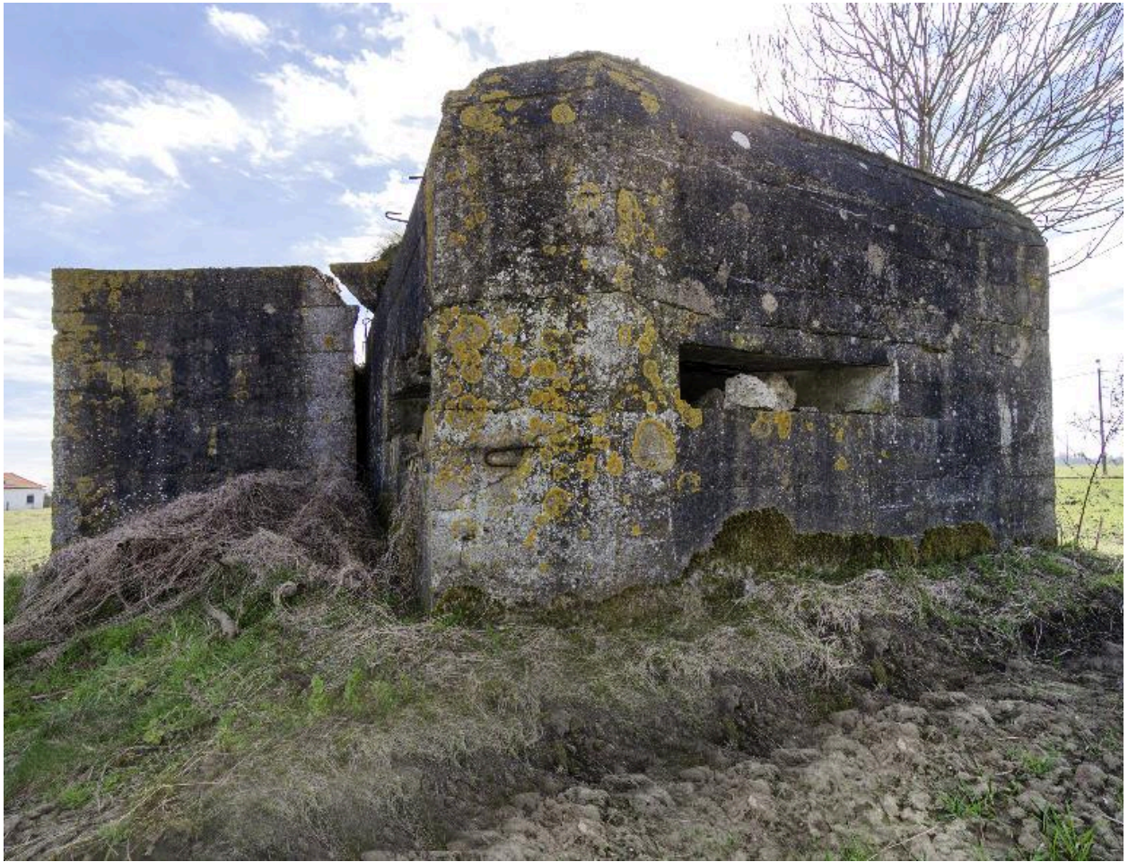
Vue générale vers le sud (au grand angulaire).
