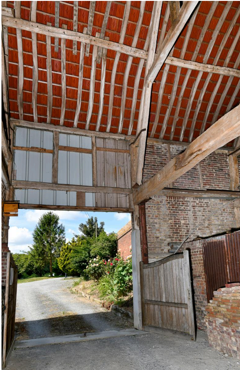
Intérieur du passage charretier, vue vers l'extérieur.
