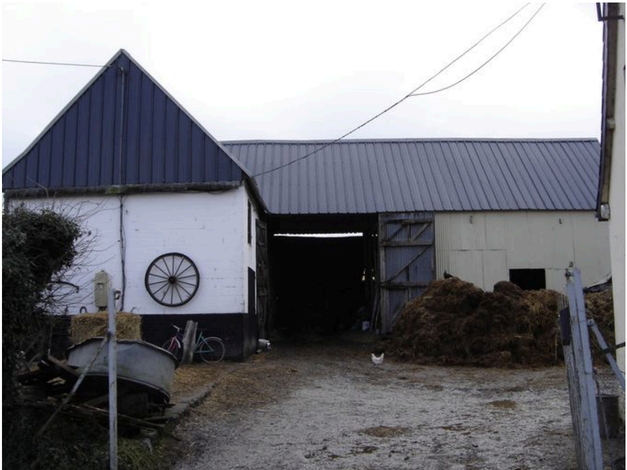
Vue extérieure de la grange.
