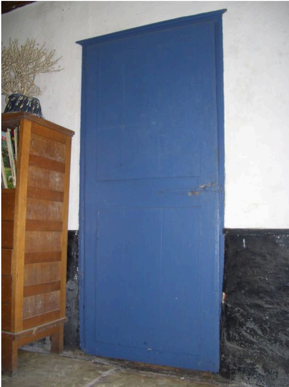
Porte menant de la salle commune à la chambre avec entablement mouluré.
