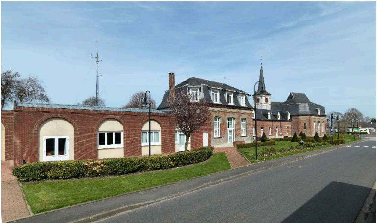
Vue générale depuis la rue Ferdinand-Buisson.
