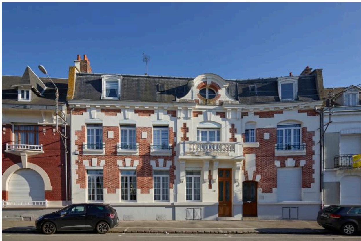
Maison, n° 16-18 rue Marcellin-Gaudefroy. Façade sur rue. Ancienne maison du docteur Baude, construite en 1922 par Eugène Bidard. Maison de style néo-classique.
