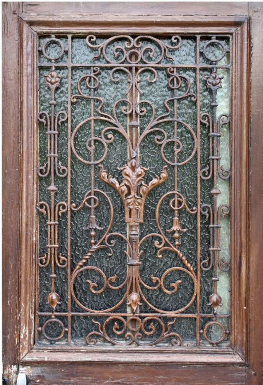
Détail de la grille en ferronnerie de la porte d'entrée sur rue.
