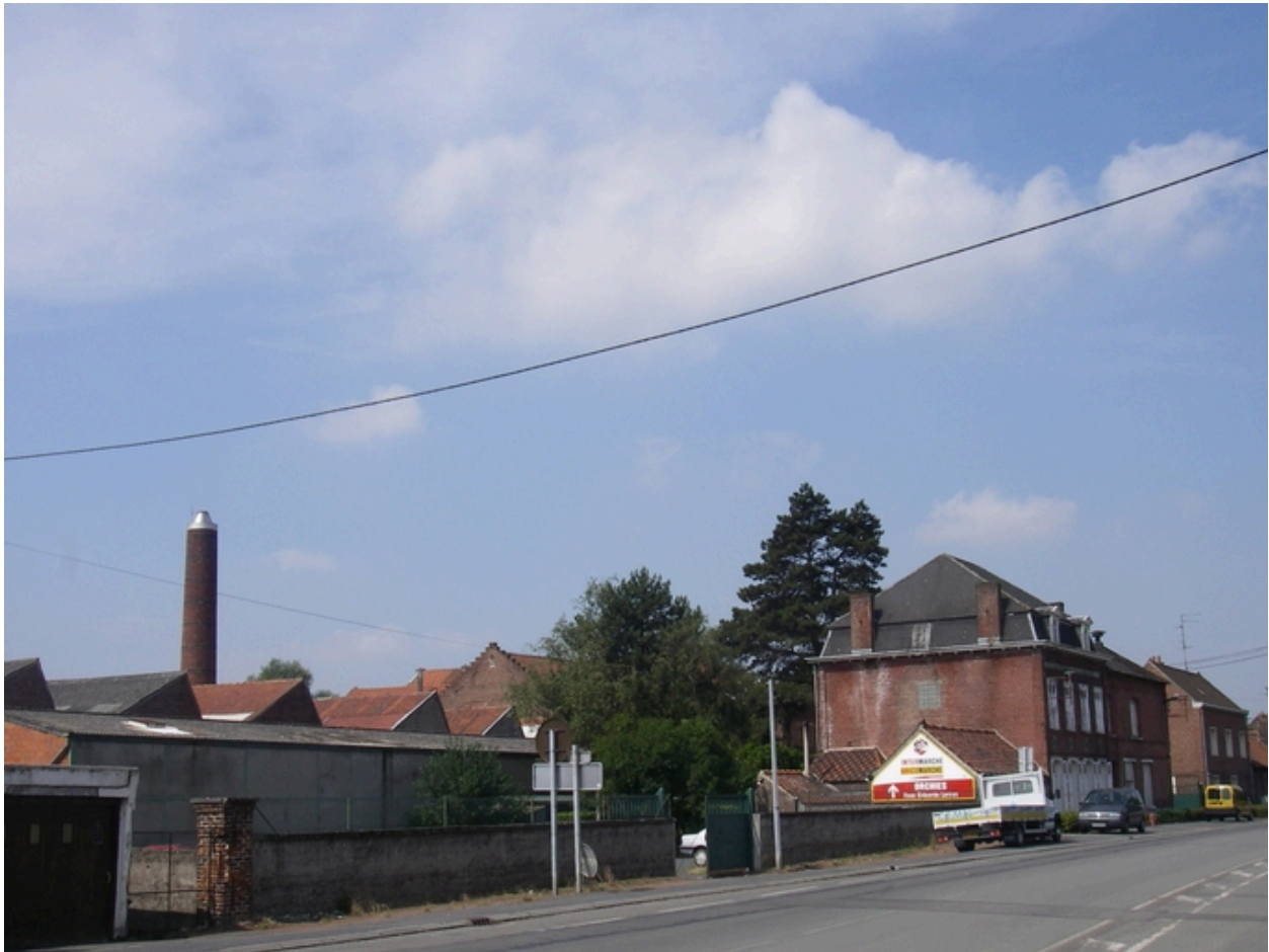
Vue générale de l'usine depuis la rue.
