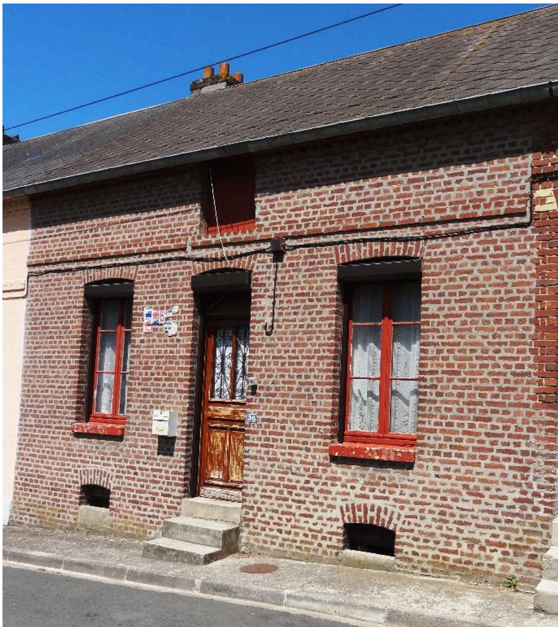
Détail du logement n°26 rue Édouard-Hérriot.
